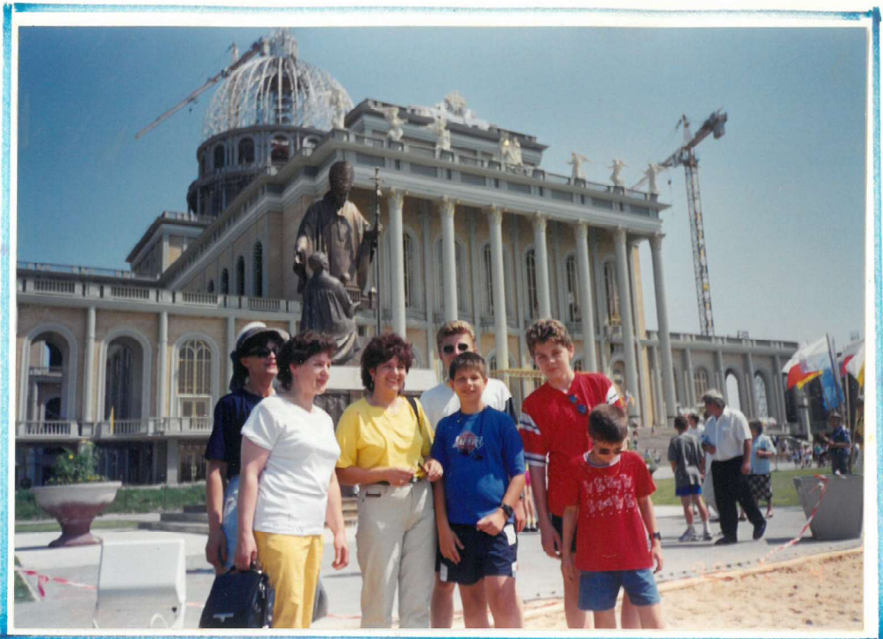
Budowa nowej bazyliki w Licheniu
