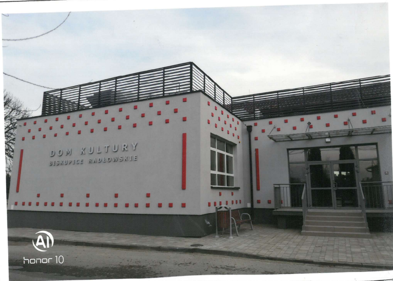
Budynek po wykonczeniu dobudowy.
